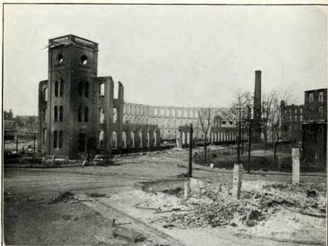
No. 5 Mill. Exterior.
